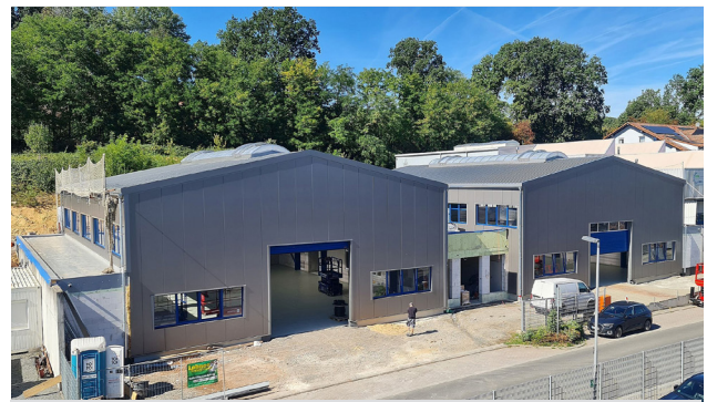
Steht kurz vor der Inbetriebnahme: Das neue Werk von ZT Odenwald, einem Unternehmen der TARTLER Group.
